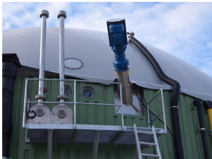
Digesteur-agitateur
