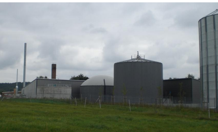
Usine de biogaz
