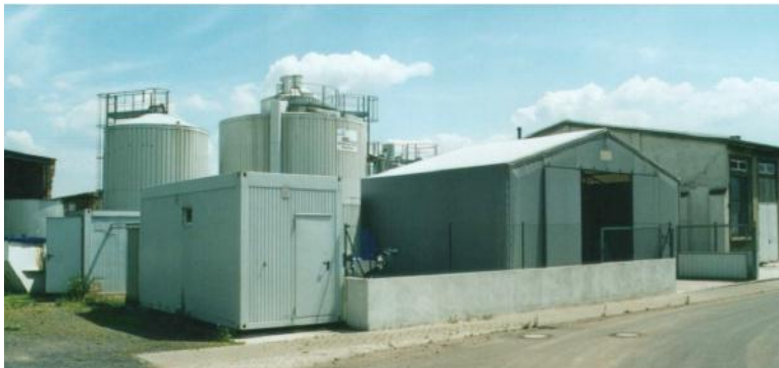
Usine de biogaz
