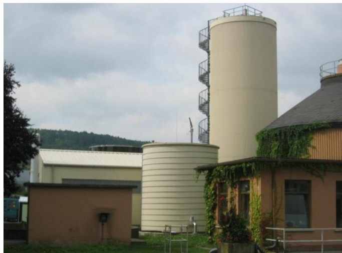
Usine de biogaz
