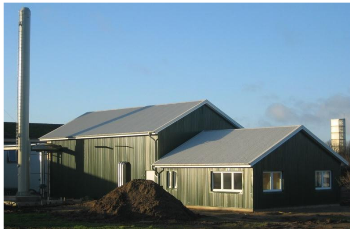
Centrale de cogénération et bâtiment de bureau
