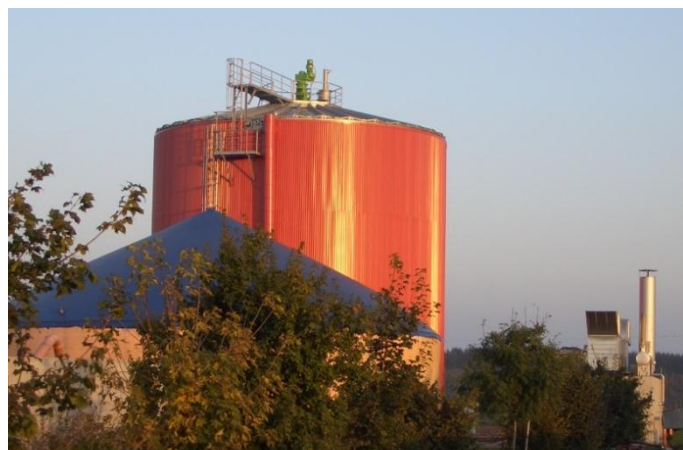
Usine de biogaz
