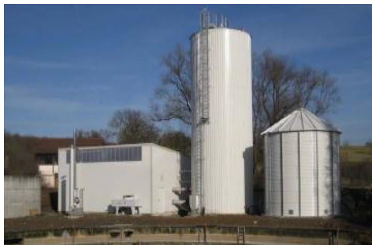
Usine de biogaz
