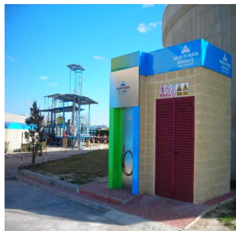
Poste de stockage et Remplissage
