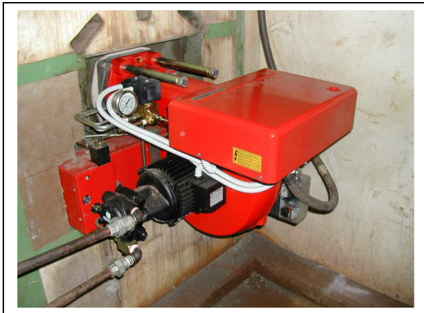
Brûleur spécial Riello/Cirad ; 34 à 110 kW Huile de coton brute, 2007. (photo Cirad)
