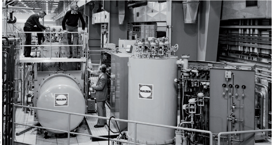
5. Réfrigérateurs 400 W à 4,5 K (Sulzer) alimentant les aimants des spectromètres de détecteurs de particules à la zone Nord du CERN dans les années 1970.
