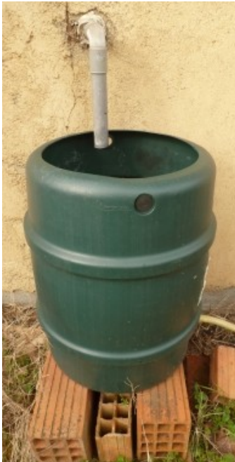
Avec ce filtre de grande taille, la paille n'est changée que tous les 6 mois (photo : Lael Delort)
