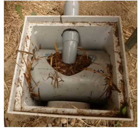
Filtre à paille conçu par Phytoépur (photo : Lael Delort)
