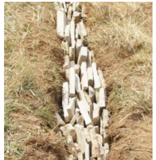
Drain d'infiltration (photo : Benjamin Broustey)
