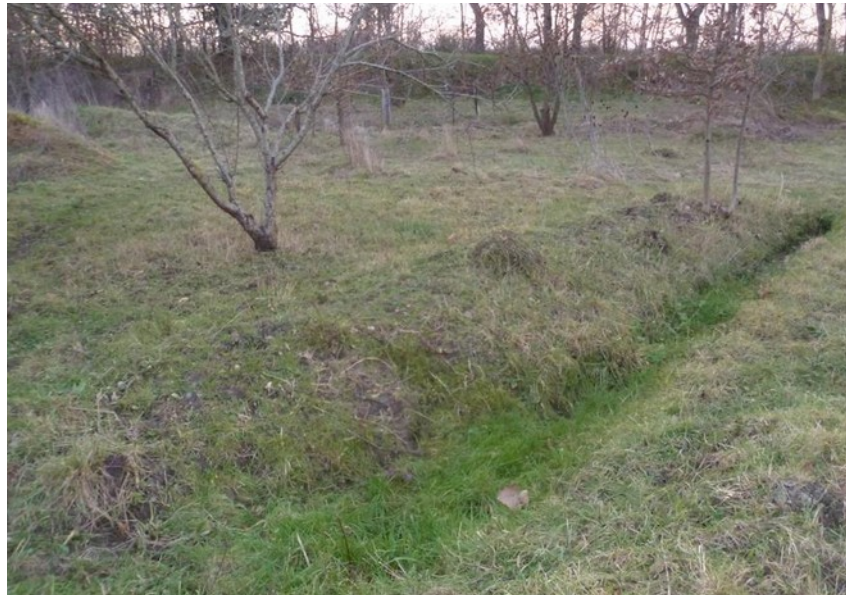
Pédo-épuration pour un foyer de 2 personnes (avec pré-traitement) dans une tranchée simple sans drain, en Haute-Garonne (photo : Pierre Besse)
