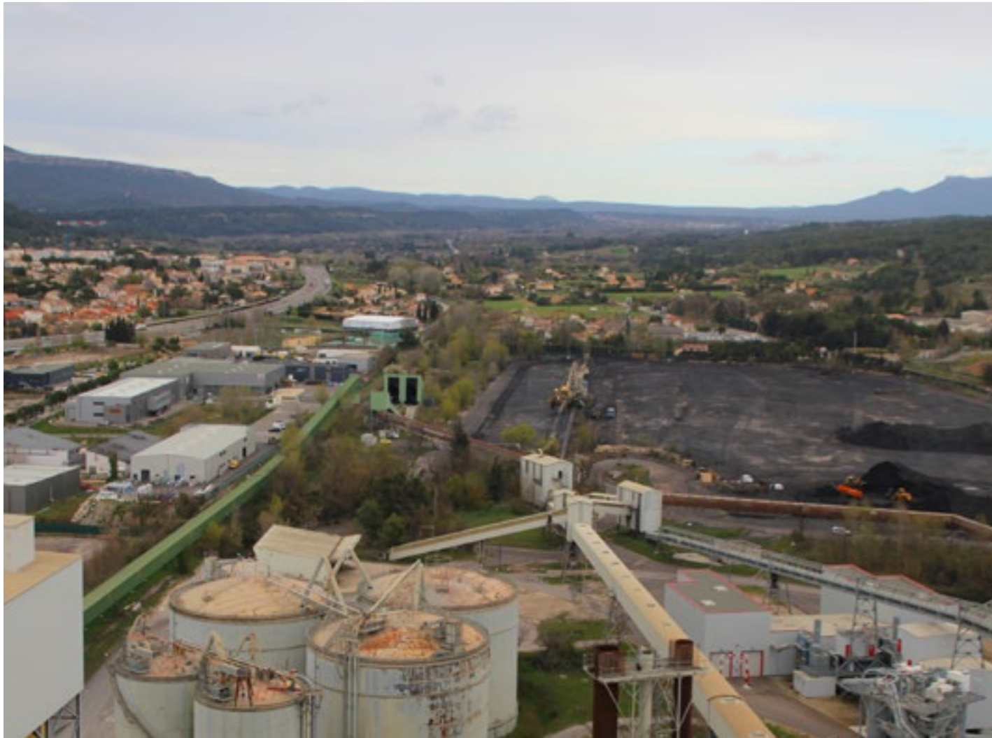
Vue sur la partie Est de la centrale - ancien parc à charbon, en reconversion foncière (implantation envisagée pour Hynovera)
